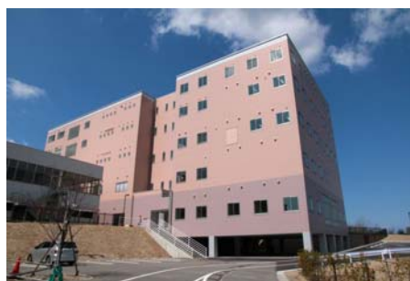
<第6研究・実習棟外観>
