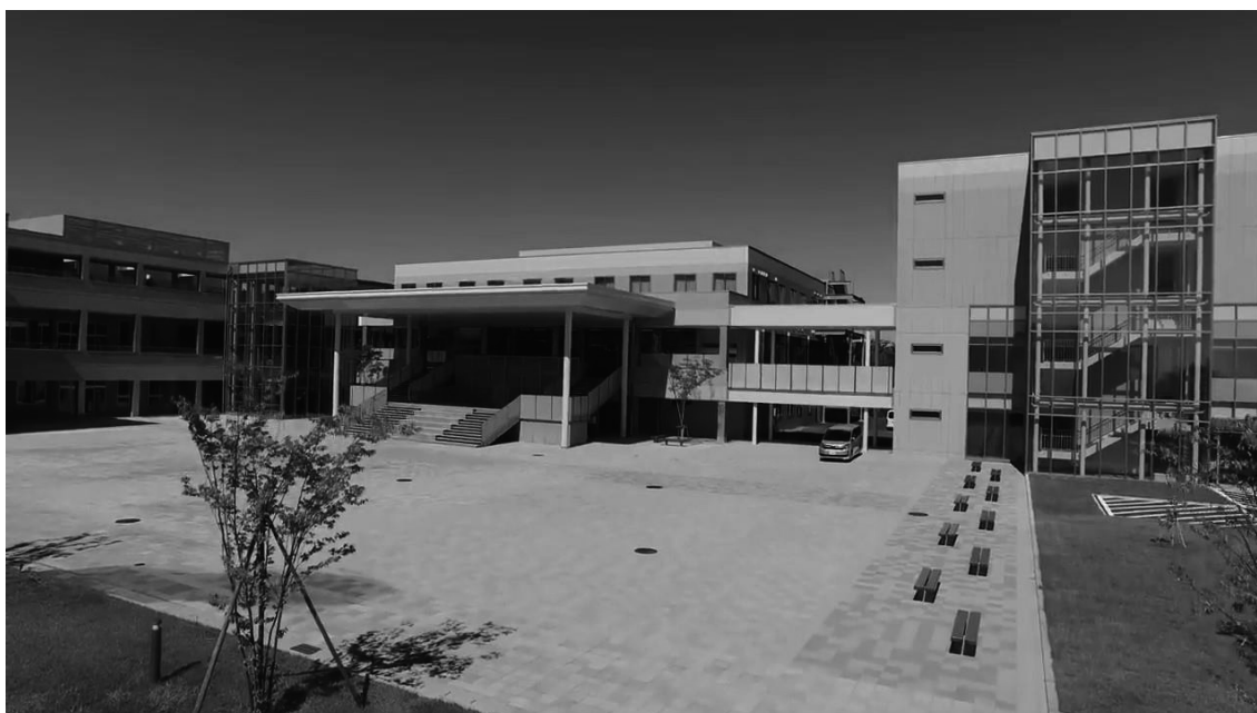
(2) S 第9研究・実習棟とT 第10研究・実習棟
